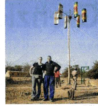
Kim Gerdes und der Spanier Santiago Oms vor der soeben gebauten Windkraftanlage.
