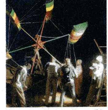
Wenn die Hitze des Tages (bis 39 Grad) zugesetzt hat, wurde nachts weiter gebaut.
